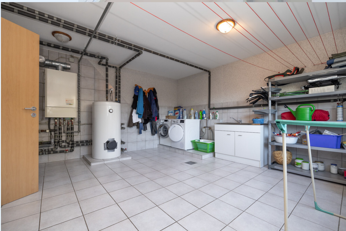
Heiz- und Kellerraum
