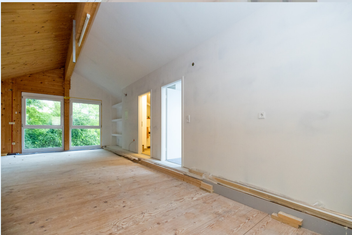
Zugang Schlafzimmer DG
